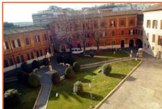
Cortile monumentale- esterno
